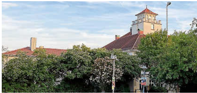
Die Filderschule mit dem prägenden Turm liegt zentral. Foto: Scherer
