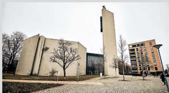
Die Kirche St. Ulrich wird umgebaut.
