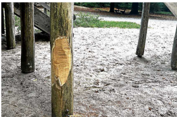
Der Standpfeiler der Rutsche wurde beschädigt.
