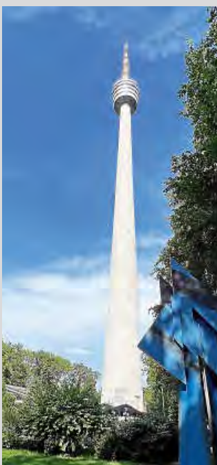
Höhere Eintrittskosten Foto: Bail
