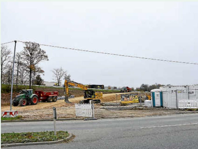
Die neue Auffahrt wird gebaut.
